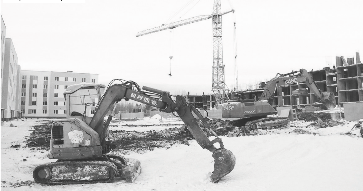
Строительство нового микрорайона на проспекте Кирова
