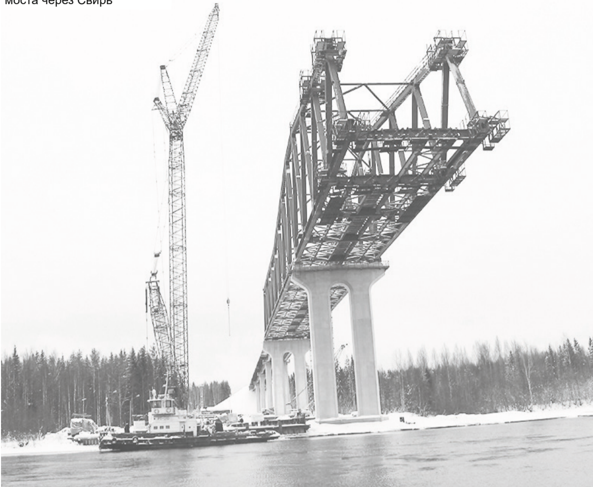
Возведение моста через Свирь
